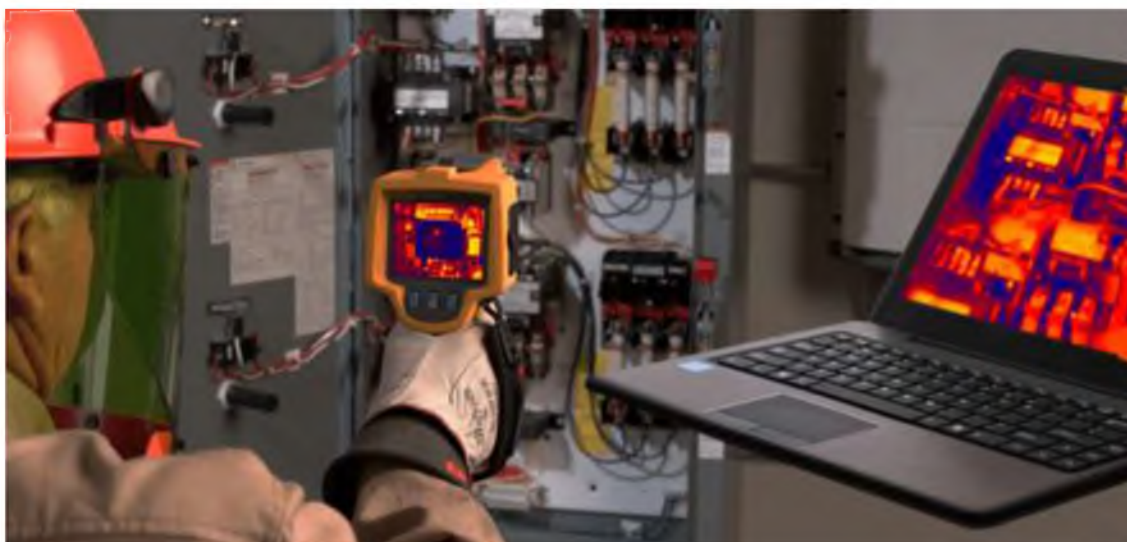
Рисунок 20. Пример проведения тепловизионного контроля электрошкафа
